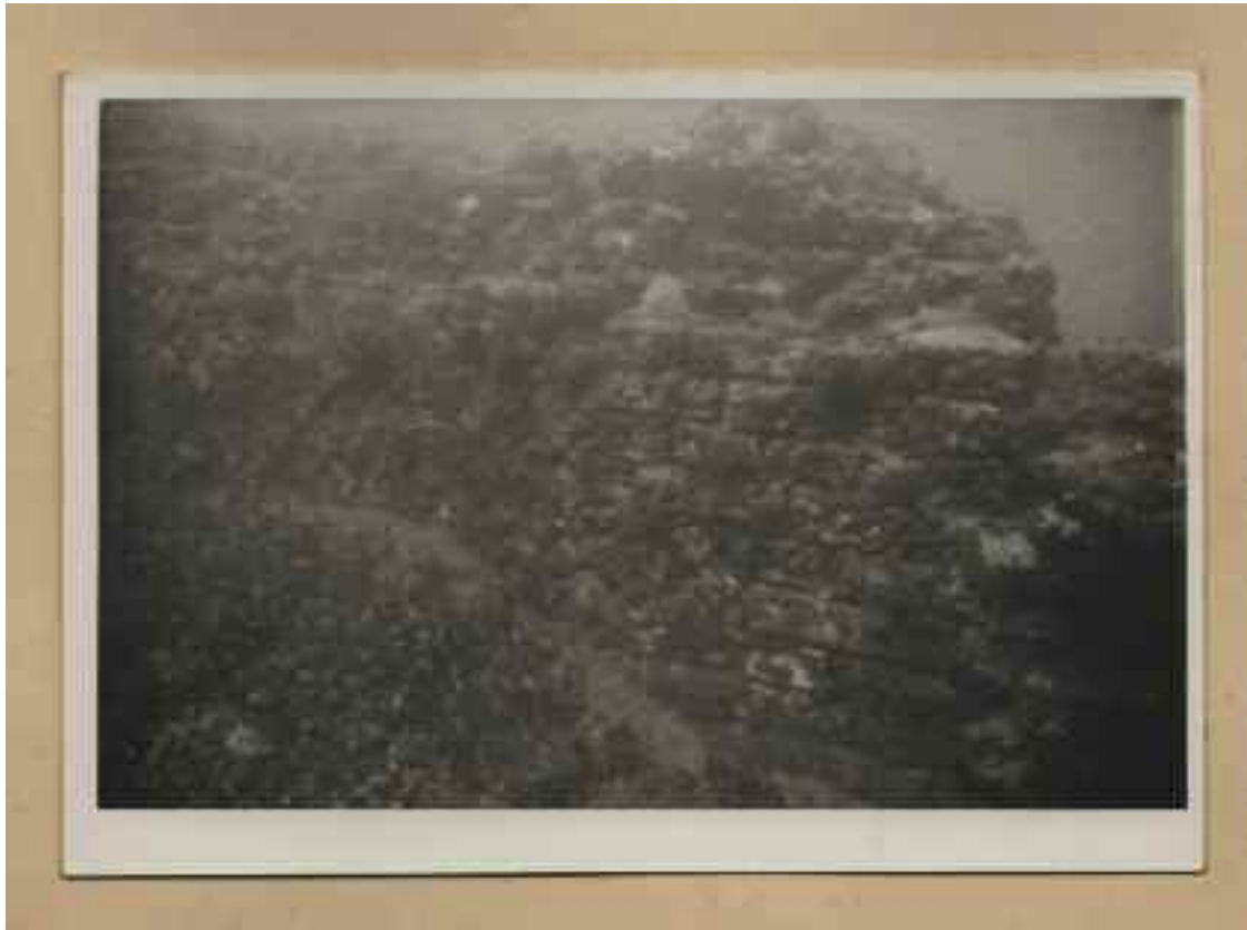
FIGURA 29 Muro in opera mista con rivestimento (foto indagini Lamboglia)
