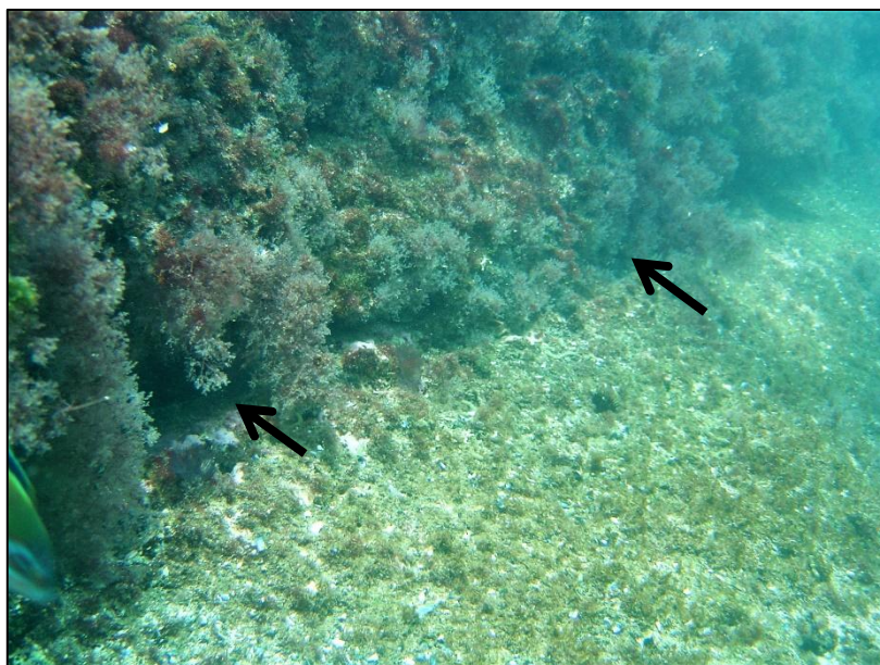
L'attacco fra la cresta di tufo e la struttura muraria.
